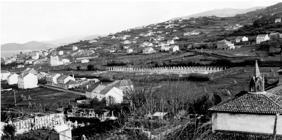
Construción Grupo Escolar de Bueu - 1970
