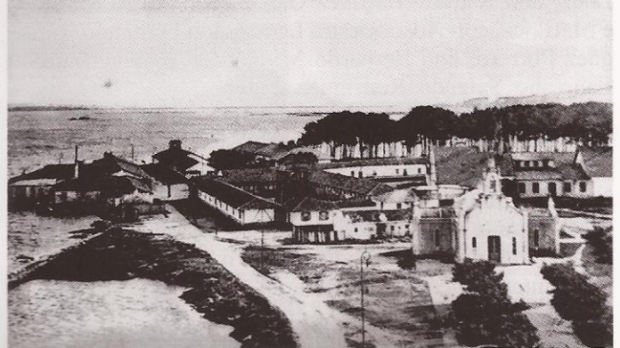
Panorámica da Toxa. Ao redor de 1908. Capela sen cunchas no seu exterior. Detrás do balneario. Ao fondo, á esquerda, a primeira fábrica de xabón.
