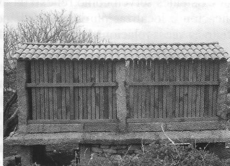
Hórreos en Sálvora, antes e despois da restauración
