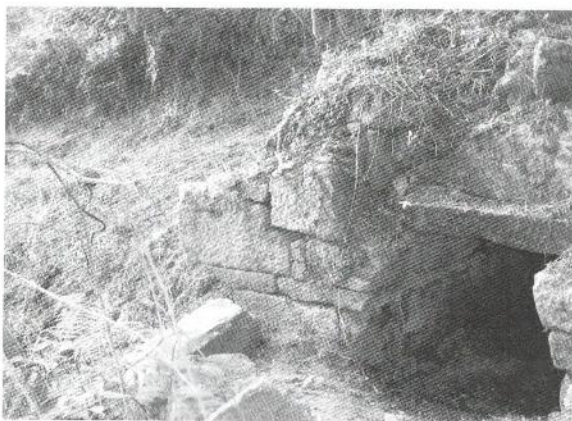
Construción moi preto da batería <Castelo da Rueda>. Pode que pertencente a esas datas e con claro uso para a batería.
