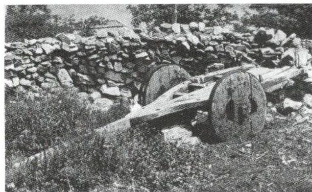
Fig. 4. Aspecto que tiña no ano 1978 un muro de mampostería construído na illa de Ons con pedras toscamente labradas e sen argamasa. (Foto: F. Alonso Romero).
