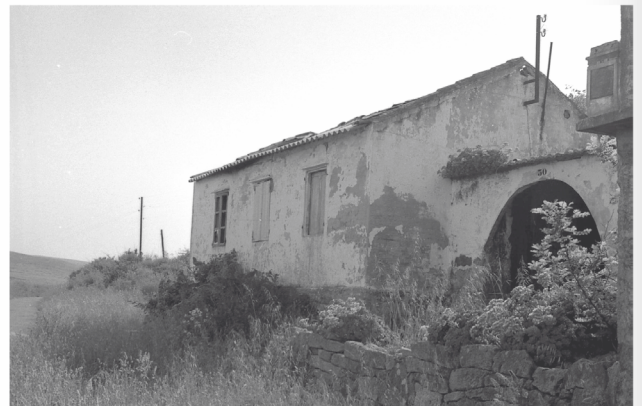
Casa que ocupou Ana Liste no lugar de Caño. Aspecto de deterioro despois de oito anos de deixala Ana. Foto: Tino Pardellas
