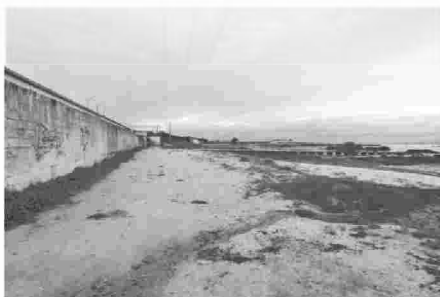
FIGURA 5. Destrucción das dunas da praia de Rons (O Grove), outubro de 2019; aparte da construción da esquerda, hai afección por tránsito de vehículos, ademais de lixo e plantas invasoras. © CDRC.
