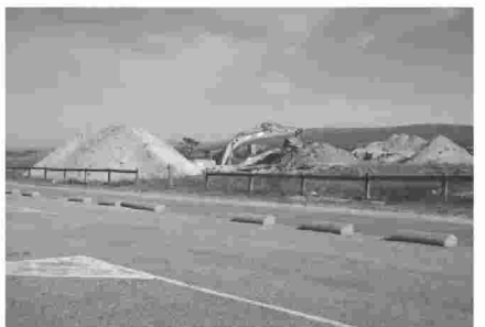
FIGURA 14. Escavacións para saneamento nas dunas protexidas da Lanzada (O Grove), en zona de cría da píllara das dunas. © EMS.
