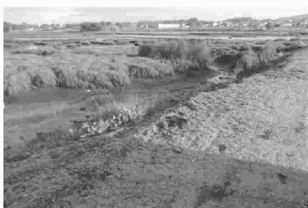
FIGURA 8. Ampliación da pista da Telleira con vertedura de inertes á marisma; entre Dena (Meaño) e A Fianteira (Sanxenxo). © EMS.
