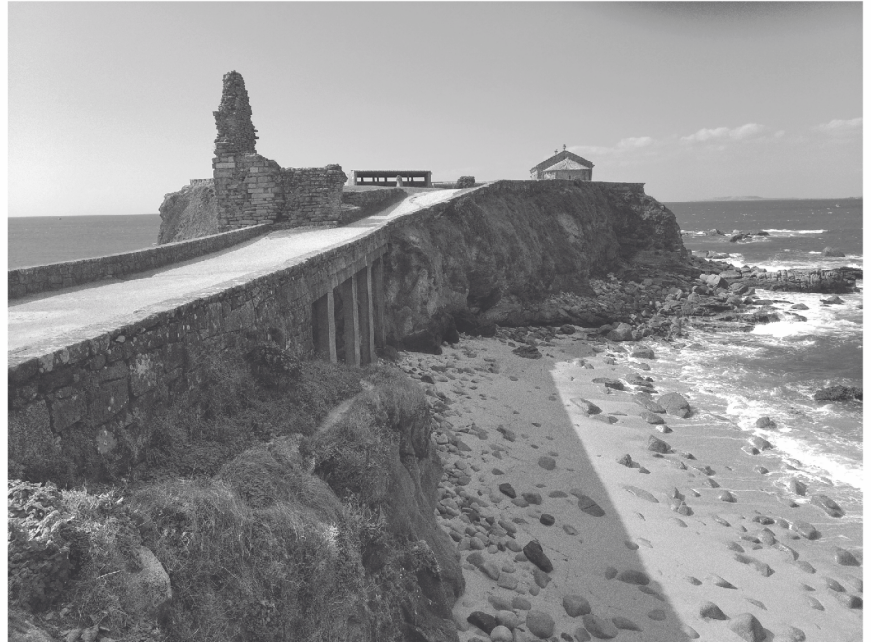
A ponte que une o illote da Lanzada con Noalla foi construída polos do Grove
