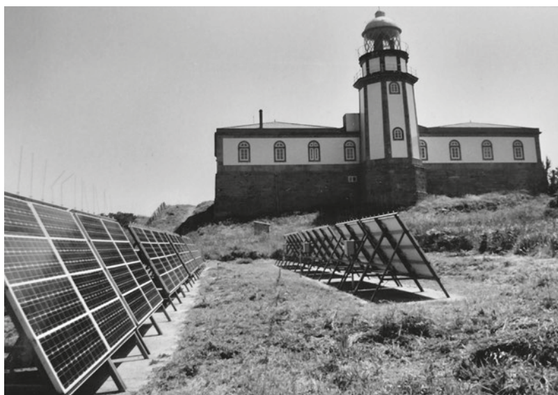
Instalación de paneis solares. Foto realizada en 1998
