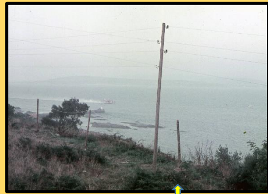
O máis que precario tendido eléctrico que foi quen de dar unha mínima luz e aguantar temporais ata a metade da década de 1990
