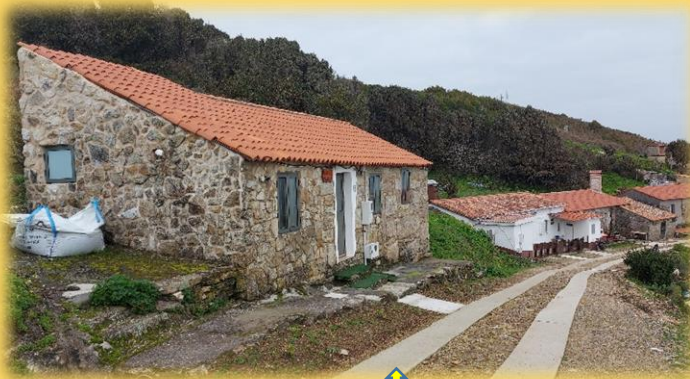
Bo estado das novas rodeiras de Pereiró, aínda que haberá que realizar algún arranxo para evitar que as correntadas, onde hai costa pronunciada, deterioren a zona de terra.
