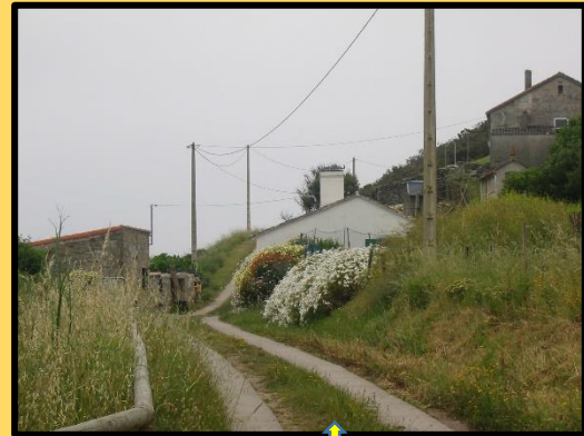
Novo tendido eléctrico, dende mediados dos 90, que aguantou fortes ventos e temporais con mínimos fallos.
