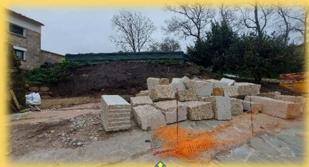
Moito material de obra. A ver se a climatoloxía os deixa traballar adecuadamente.
