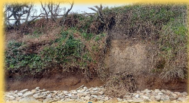
Graves desprendementos de terra ao longo de todo o cantil de Canexol. Perigo para as cubas de salga romanas e con risco para o camiño cara a Pereiró.
