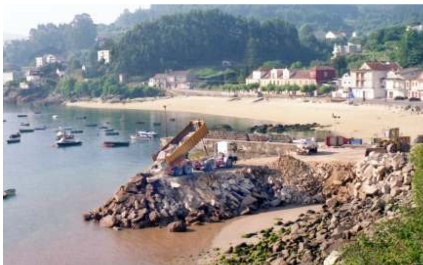
Comezo das obras do porto de Beluso. Xuño 2001
