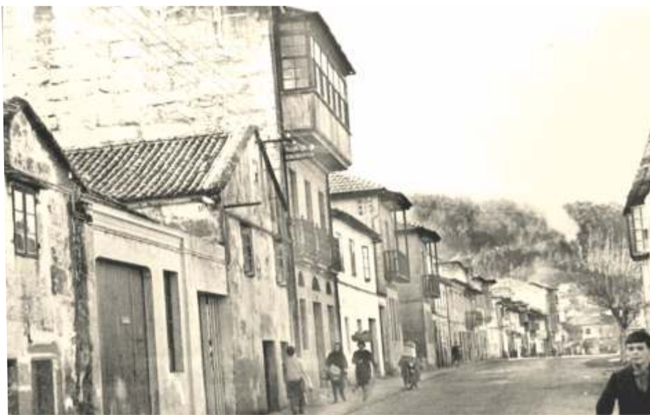
Rúa Montero Ríos onde estaba a vivenda e salga da familia Agulla-Solabarrieta
